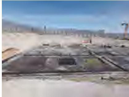
1号地块-西北侧
