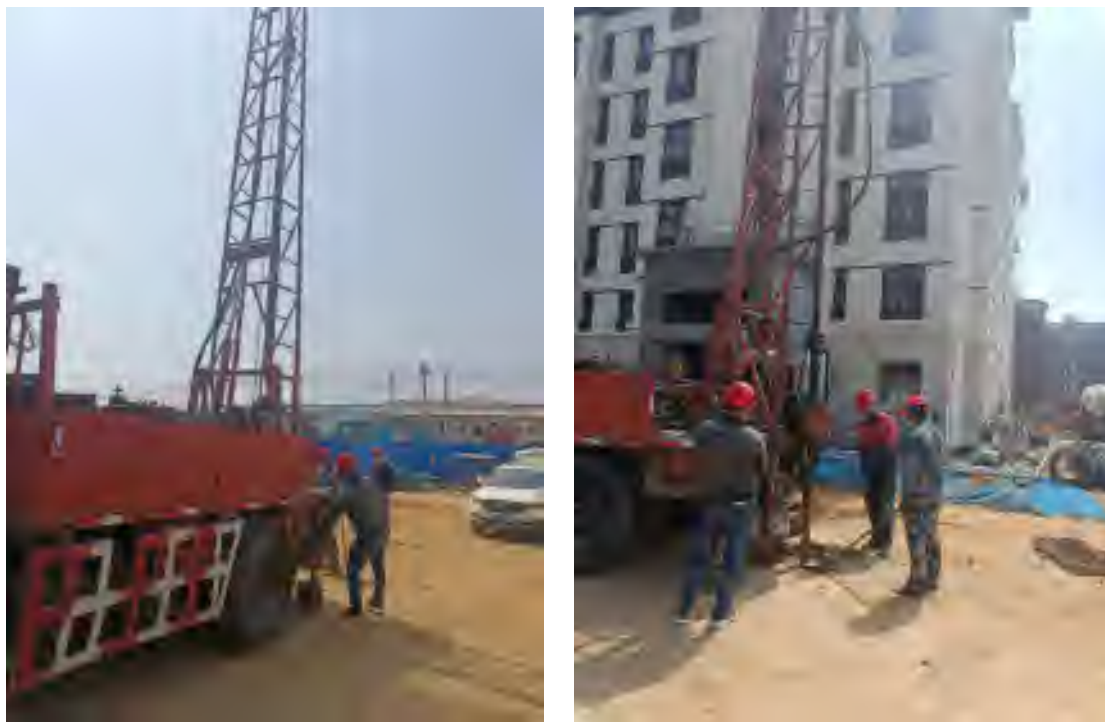
图 8.3 钻探车采样照片
